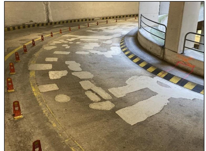
Verfüllung von Schadstellen im Belag.
