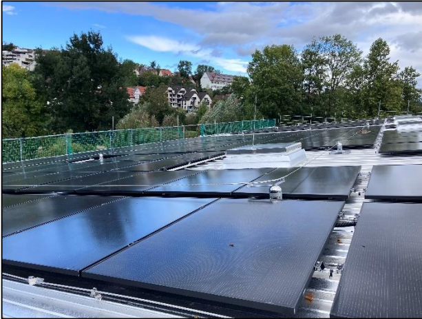
Energetische Dachsanierung mit PV-Anlagen.
