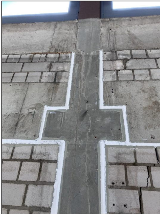
Rückbau der PCB- Fugenmassen und Neuverfugung.
