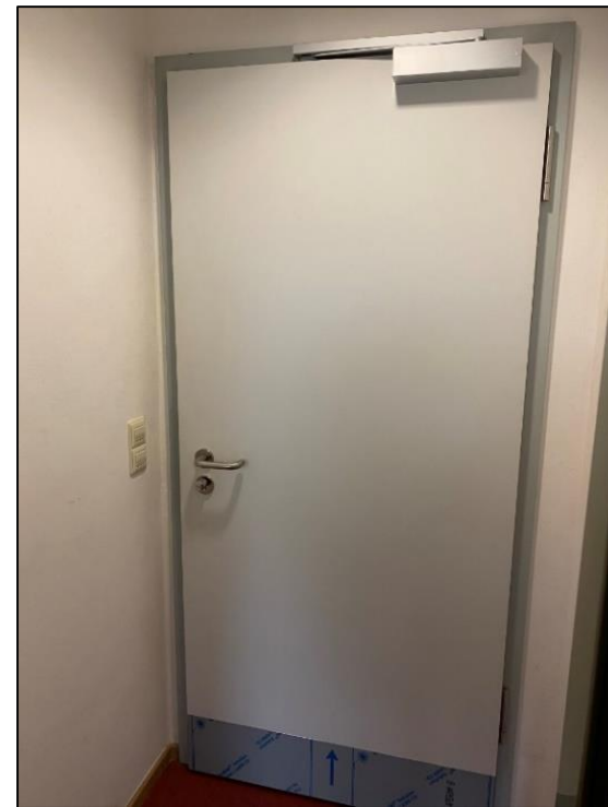
Die neuen Schallschutztüren.
