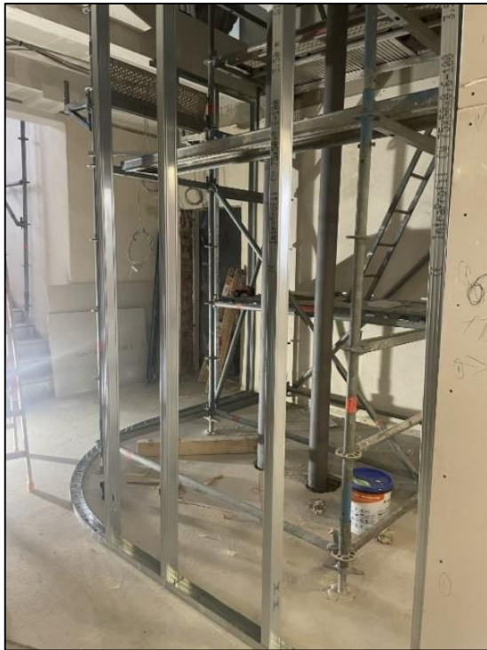
Einbau eines Fluchttreppenhauses.
