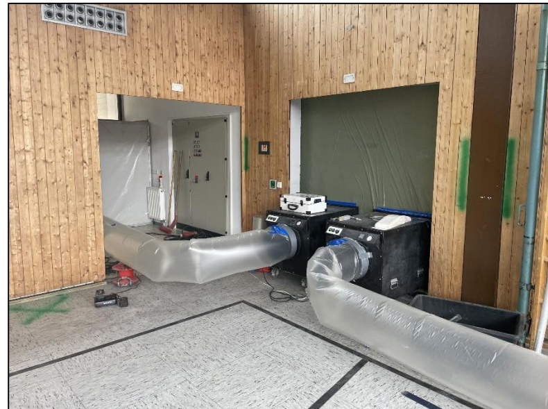
Zur Reduktion des PCB-Gehalts der Raumluft werden die Räume mit Gebläsen abgesaugt.
