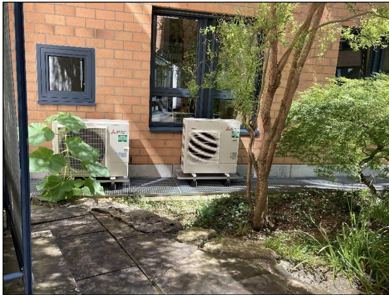
Die neuen Klimaanlage für das Archiv: Außen...
