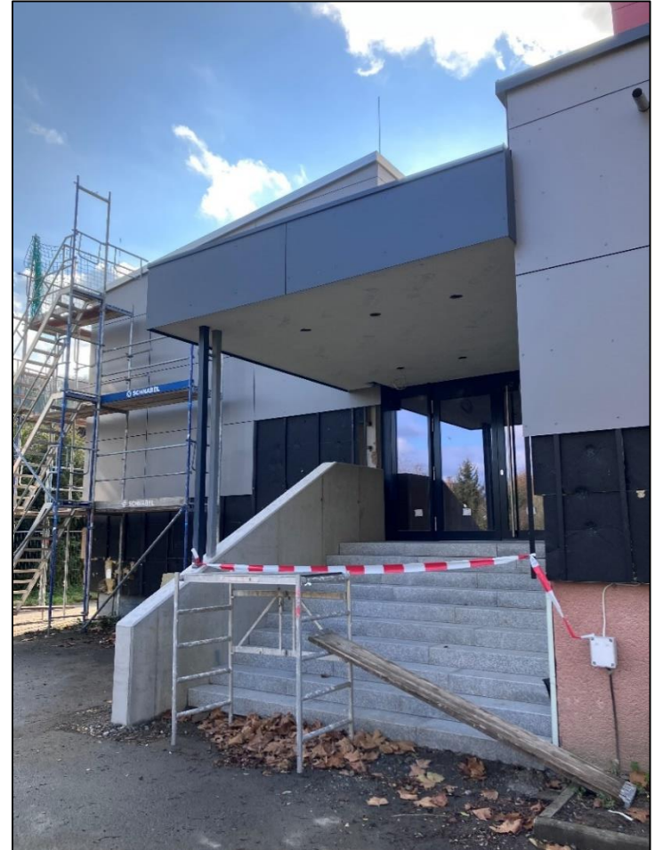
Sanierung der Außenanlagen.
