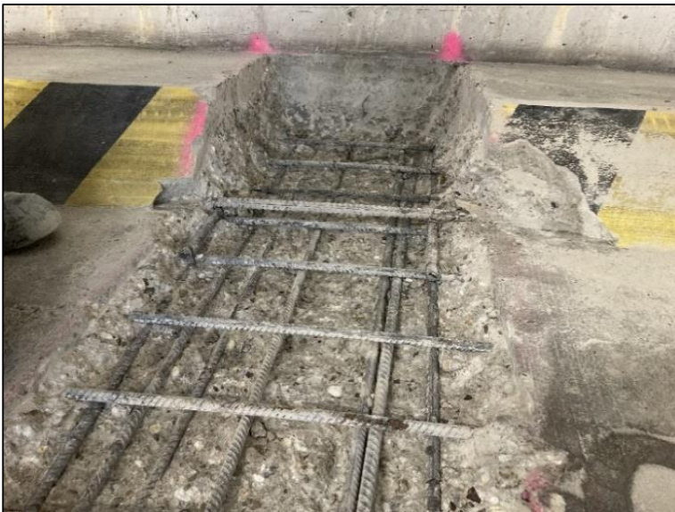
Prüfung und Entrostung der Bewehrungseisen.
